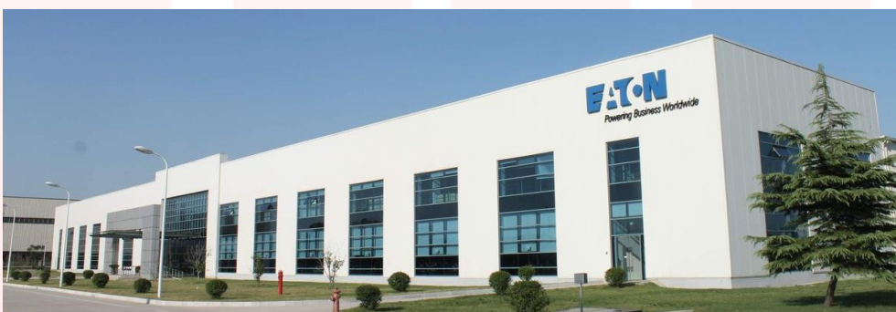
Instalaciones de Eaton en Santo Domingo, República Dominicana
