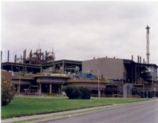
*Instalaciones de refinería electrolítica en México
